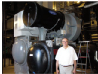
Profesors Lešinskis devis nozīmīgu ieguldījumu Latvijas Nacionālās bibliotēkas jaunās ēkas gaisa kondicionēšanas risinājumā, kur ēkas dzesēšanai tiek izmantots Daugavas ūdens un patreiz Latvijā jaudīgākais 4 MW kompresijas dzesētājs.
